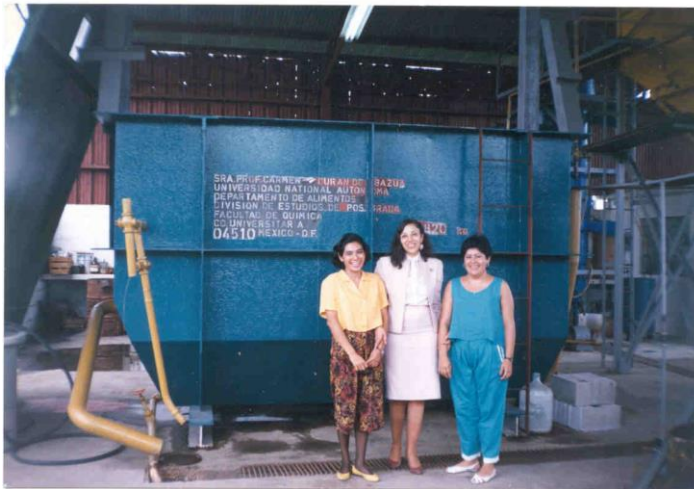
Figura 3. Reactor aerobio de biodiscos donado por el Gobierno de la República Federal de Alemania que recibe los efluentes tratados en un RALLFA como parte de una planta completa.
