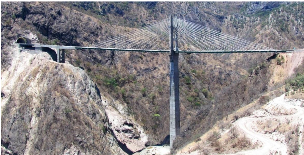
Figura 1. Puente “El Carrizo”, vista panorámica
